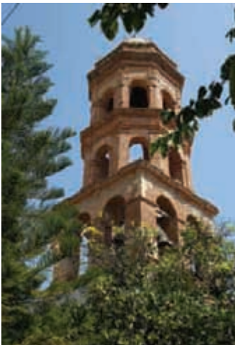
Torre del campanario
