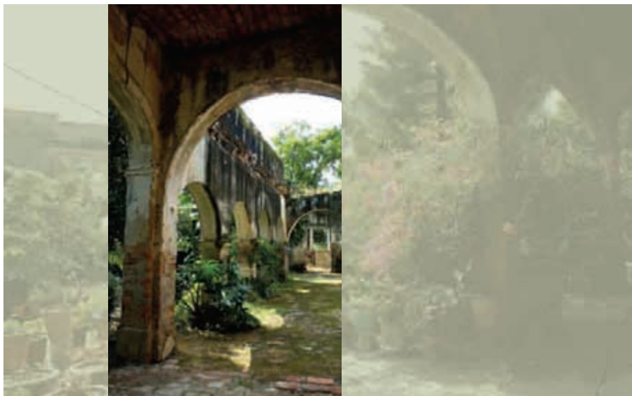
Vista general de la arcada de la Hacienda de Navajas
