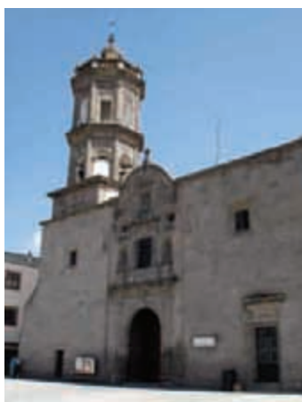
Portón de entrada principal
