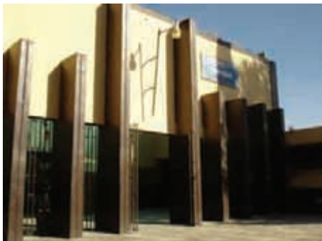
Casa de la Cultura de Tala. Fachada
