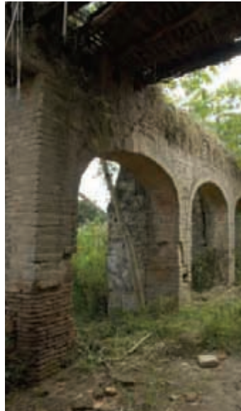
Arquería en uno de los patios
