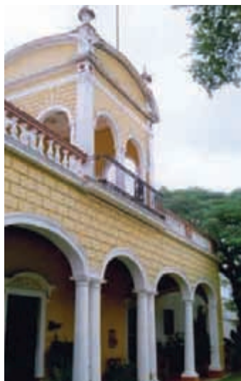
Fachada principal de la hacienda
