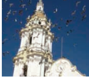
Torre del Templo, San Francisco de Asís
