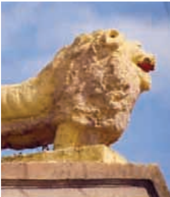
León de cantera sobre el arco de la entrada
