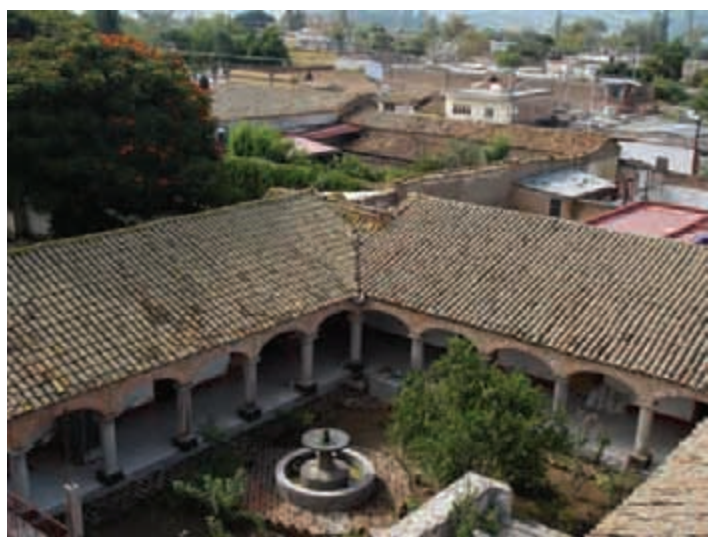
Claustro de la iglesia de San Marcos
