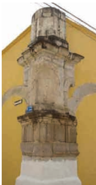
Detalle en esquina; columna de la Casa de Moneda
