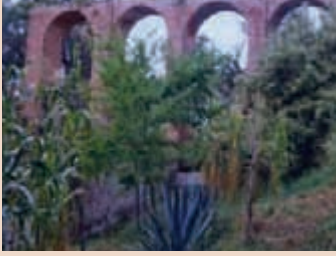
Acueducto de la hacienda de San Juan de los Arcos
