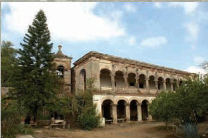
Fachada principal de la hacienda
