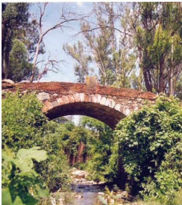
Puente sobre el arroyo Santa Clara
