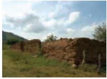
Muros de adobe
