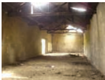
Interior de la estación
