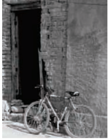
Muros de adobe y ladrillo
